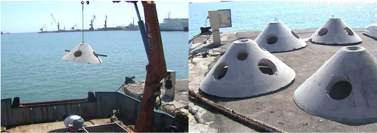
Εικ. 3. Καινοτομικός τύπος προστατευτικού υφάλου κατά τη φάση μεταφοράς και πόντισης στο Υποθαλάσσιο Τεχνολογικό Πάρκο Κρήτης (δίπλωμα ευρεσιτεχνίας, ΟΒΙ αριθ. 1004153, εφευρέτης Κώστας Ντούνας).
