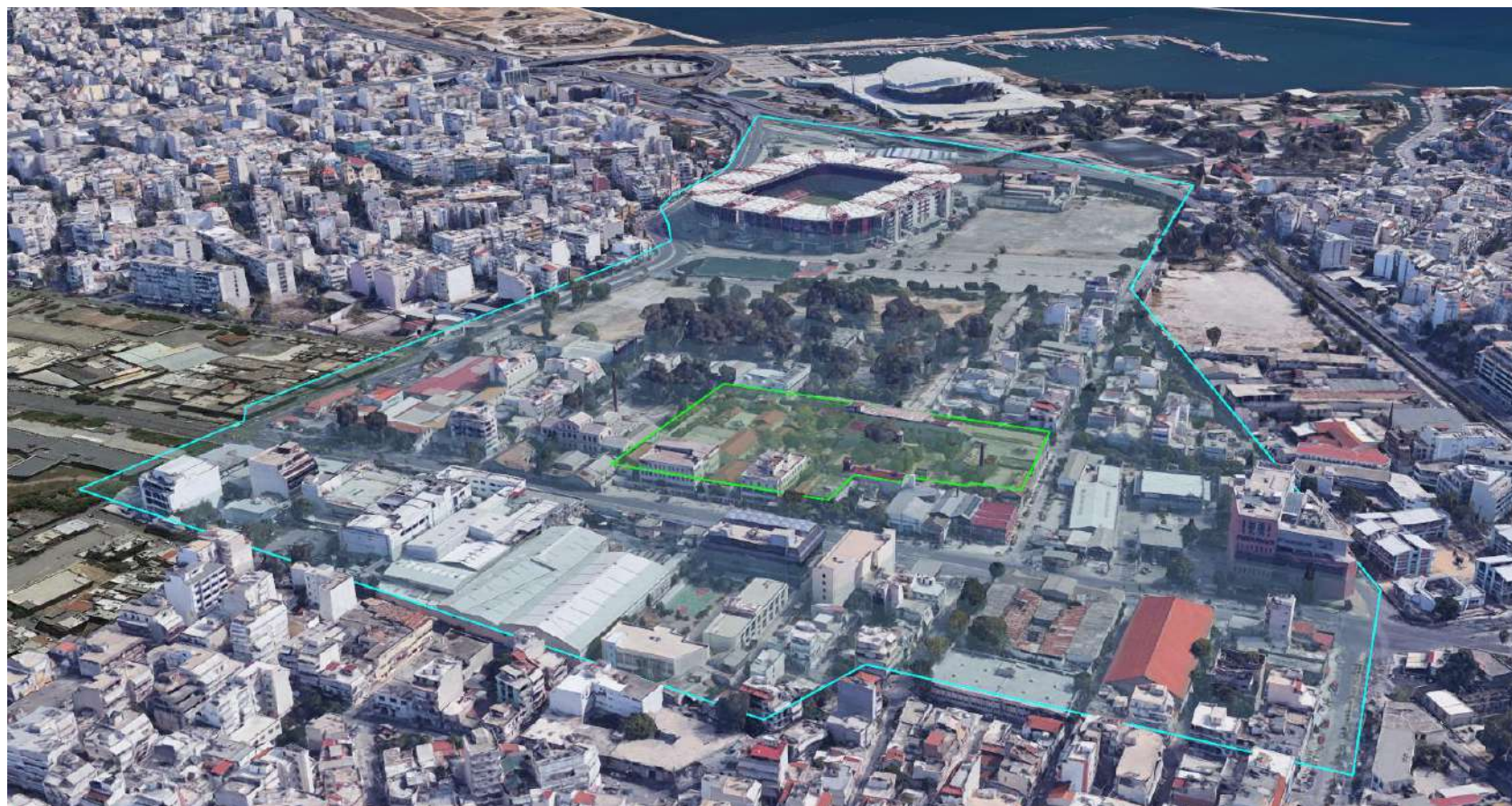
Εικόνα 4.8: Άμεση ζώνη επιρροής ΕΠΣ (γαλάζιο πολύγωνο) και περιοχής επέμβασης (πράσινο πολύγωνο). Θέα νοτιοανατολικά. (υπόβαθρο: GoogleEarth - δορυφορική φωτογραφία).
